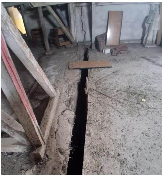
Fig.4. degradari in jurul rosturilor seismice
