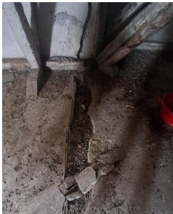
Fig.4. degradari in jurul rosturilor seismice
