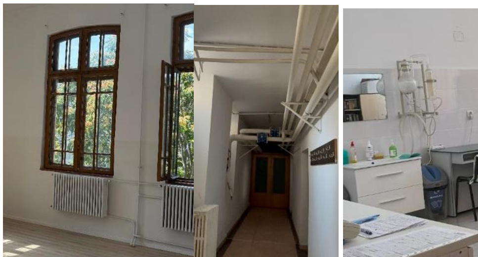
Figura 7 – sistem incalzire si preparare a.c.c.
