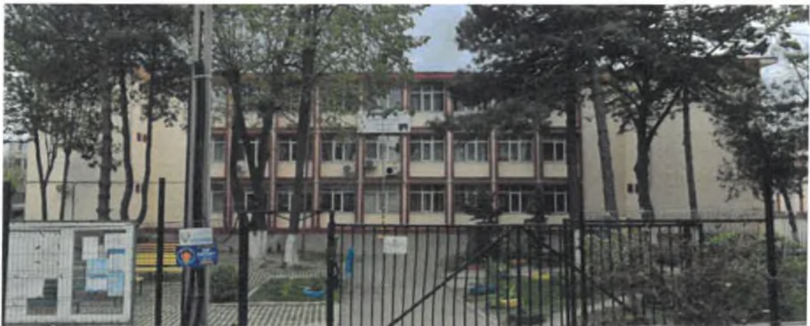
Figura 1 – Fațada Nord-Vest, către stradă
