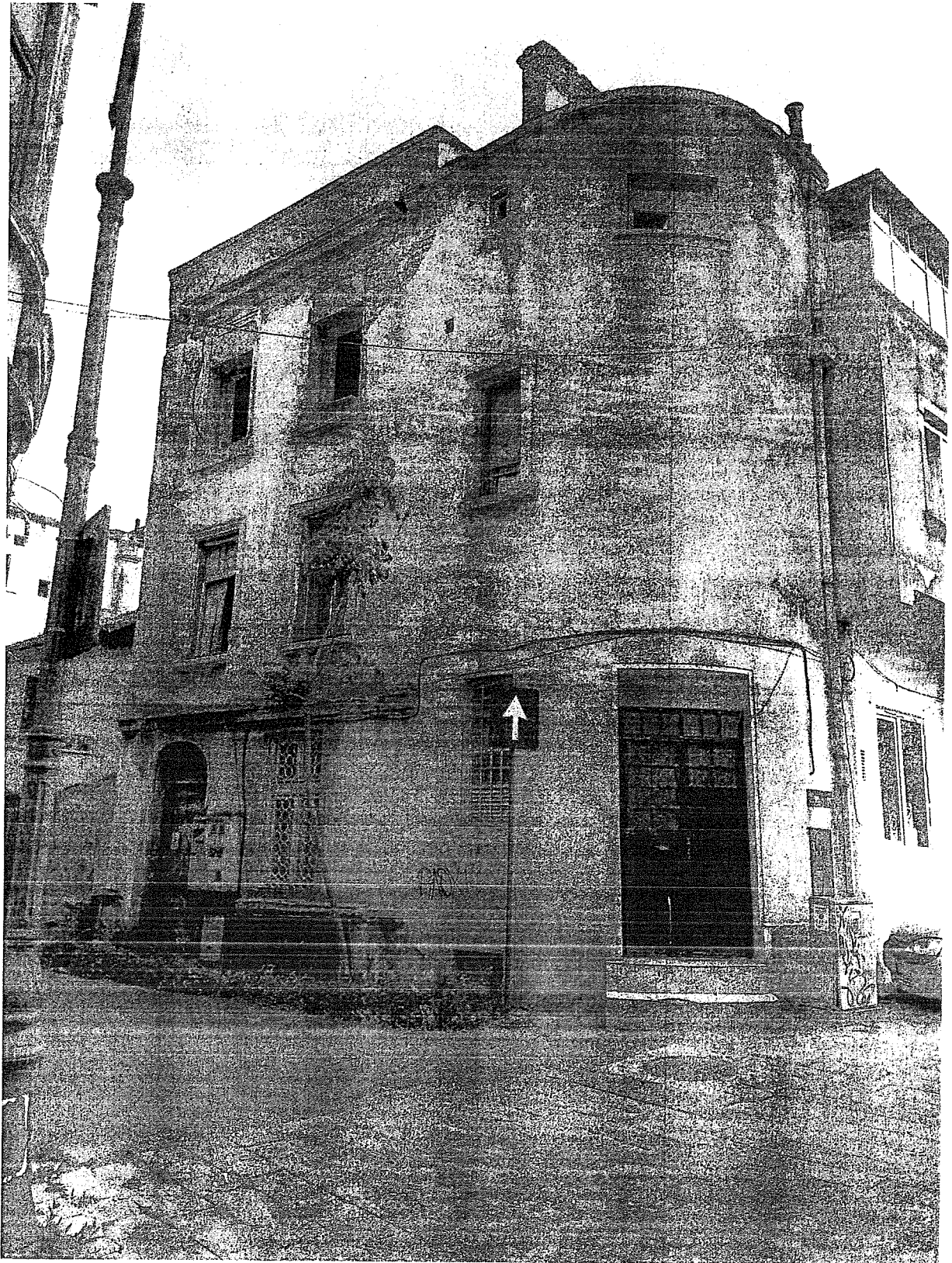
Fatada secundara (str. Orientului nr. 15)
