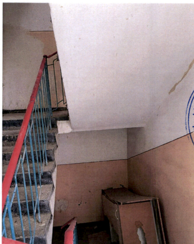
-Rost prindere scara si perete structural-
