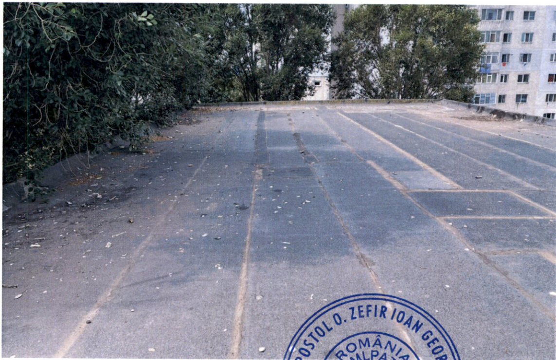
-Degradare straturi terasa-
