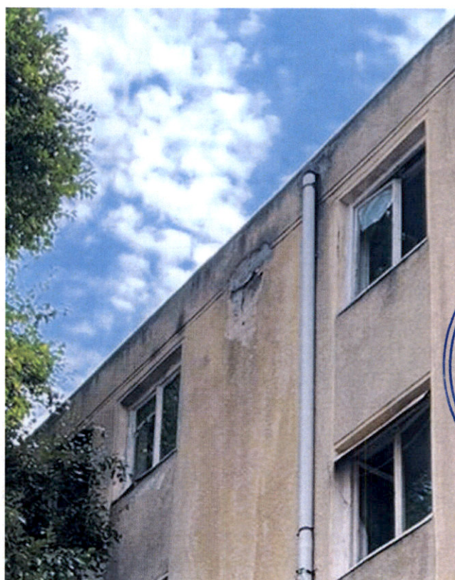
-Zona cu cedari locale tencuiala, fisuri si infiltratii in peretii de fatata-
