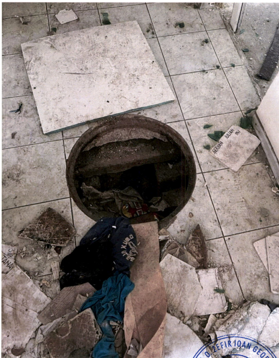
-Sistem canalizare infundat
