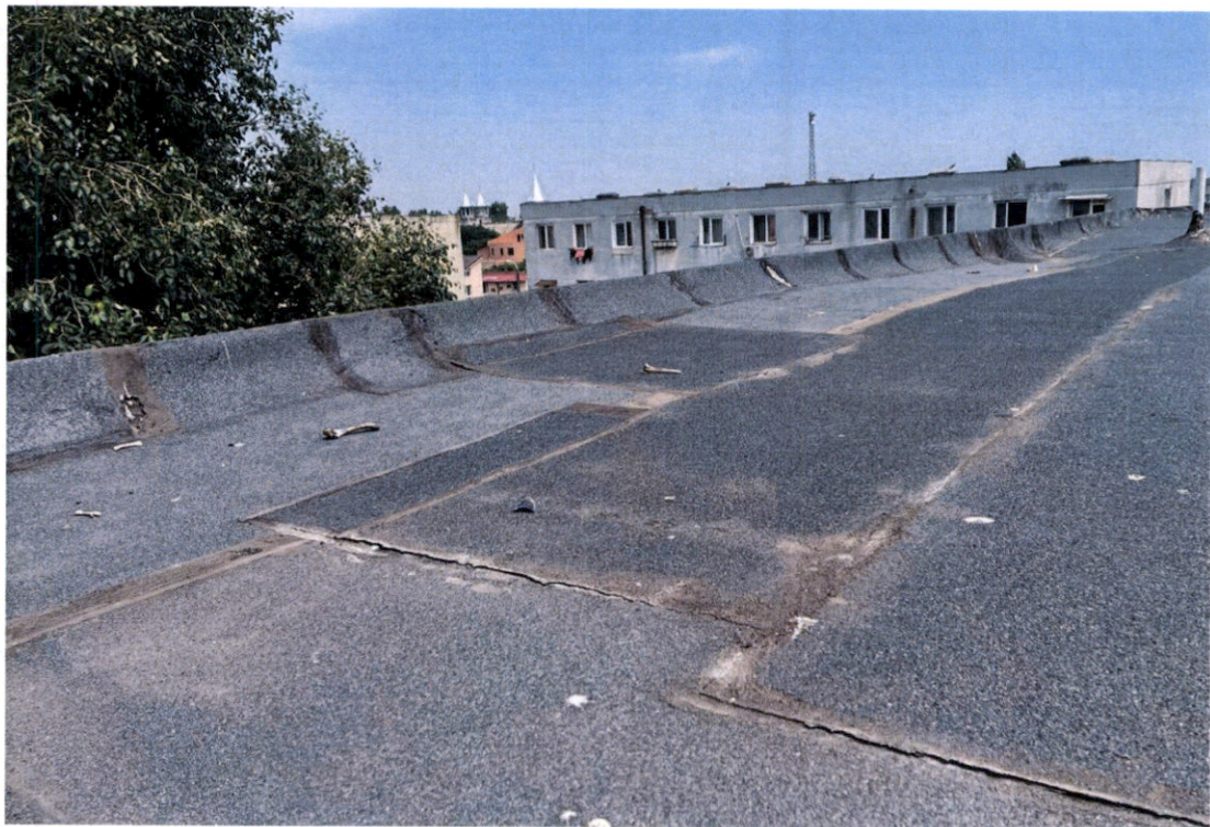
-Degradare straturi terasa-
