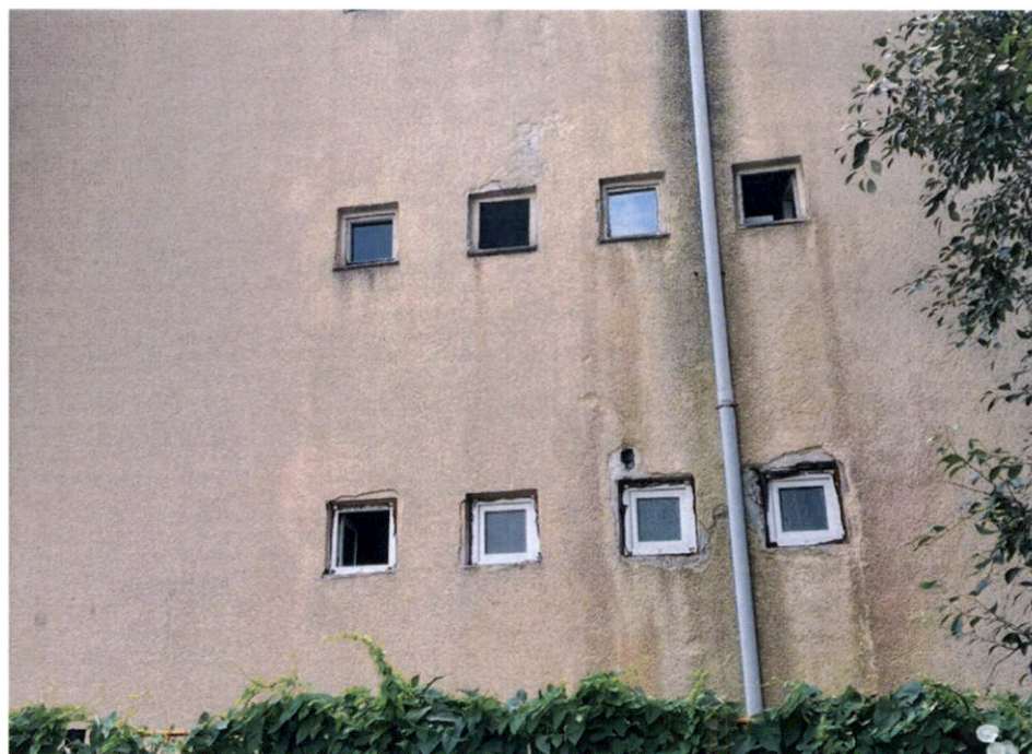
-Zona cu cedari locale tencuiala, fisuri si infiltratii in peretii de fatata-
