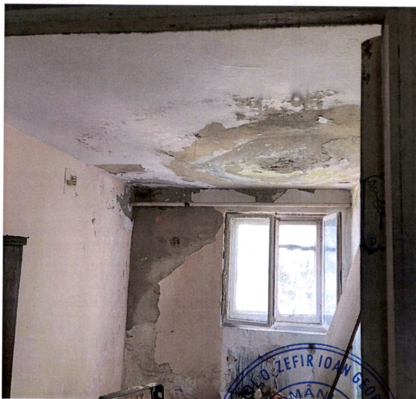
-Fisuri la nivelul peretilor si planseului cat si infiltratii de apa si degradare finisaje-
