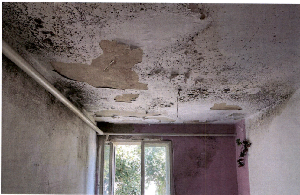
-Fisuri la nivelul peretilor si planseului cat si infiltratii de apa si degradare finisaje-
