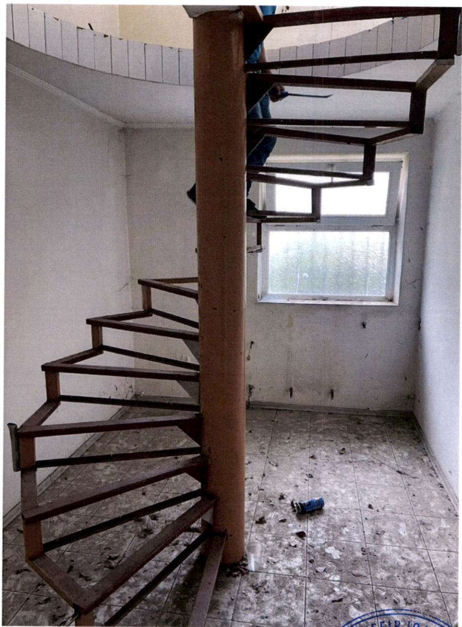
-Scara tip circulara fara finisaj pe trepte sudura ruginita-
