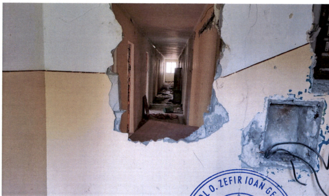
-Degradari majore de finisaje si cedari partiale elemente-
