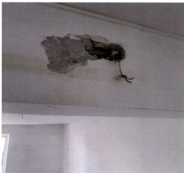
-Degradare acoerire cu beton a armaturilor-
