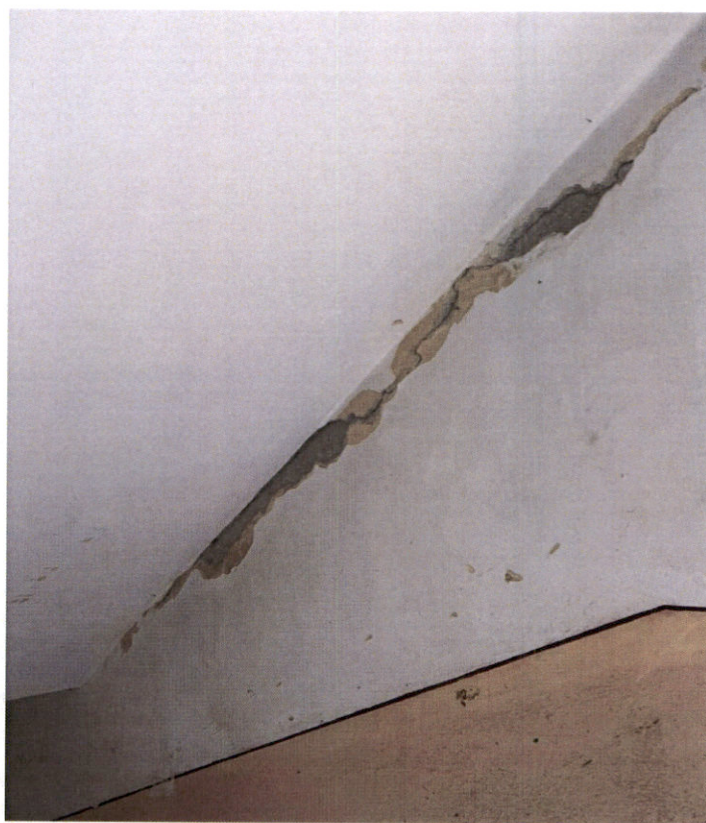
-Rost prindere scara si perete structural-
