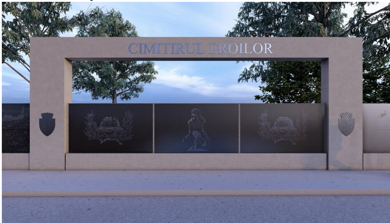
Semnalizarea Cimitirului Eroilor – Str. I.L. Caragiale – portal din beton placat cu piatră naturală în zona fostului acces către Cimitirul Eroilor.
