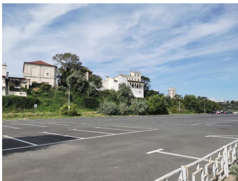
Figura 8. Perspectivă ascendentă, din zona care a generat P.U.D., către Biserica Armenească „Sfânta Maria” (stânga) și Vila Suțu (dreapta) – septembrie 2022.
