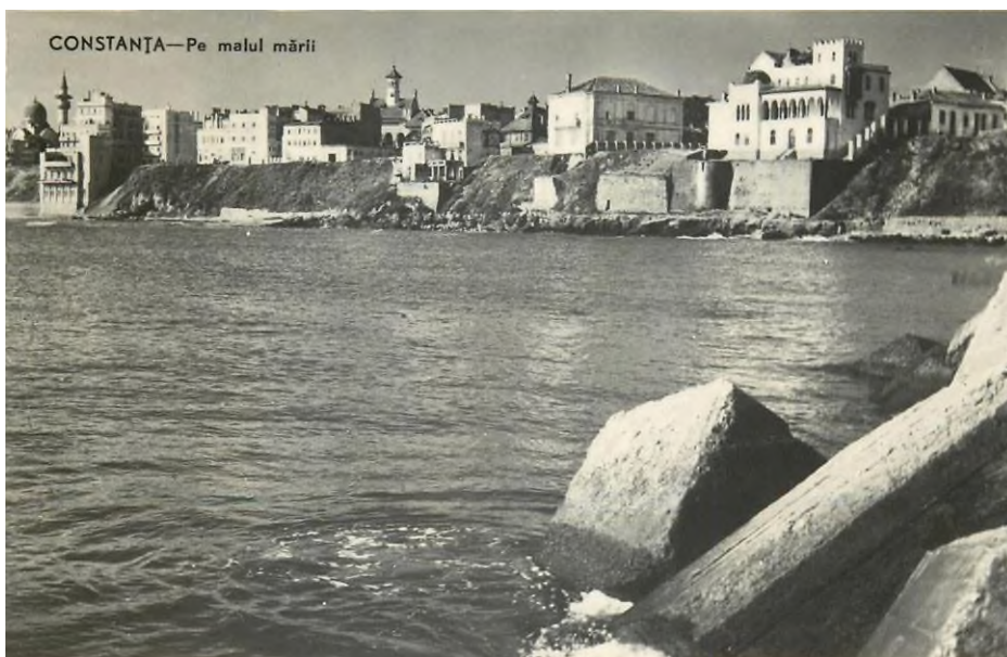
Figura 9. Perspectivă asupra zonei care a generat P.U.D. – se remarcă poziționarea promontoriului/taluzului pe care se află Vila Suțu și Biserica Armenească la malul mării. Sursa: https://oradea-nagyvarad-grosswardein.ro/page/25/ . Accesat la 21.07.2023.
