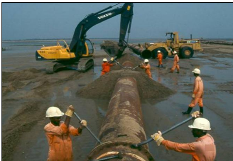
Instalarea unei conducte de innisipare. Exemplu
