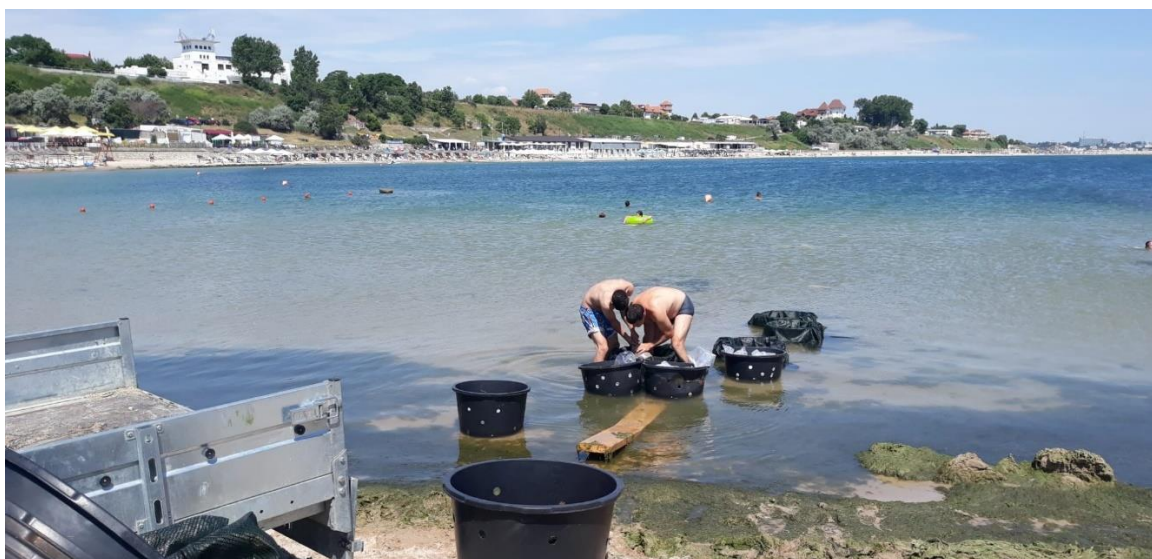
Umplerea cosurilor cu nisip in zona Capul Turcului
