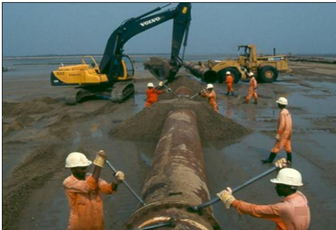
Instalarea unei conducte de reinnisipare. Exemplu
