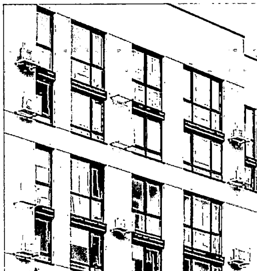
Exemplu de mascare a aparatelor de aer condiționat amplasate pe fațadă cu tablă perforată
