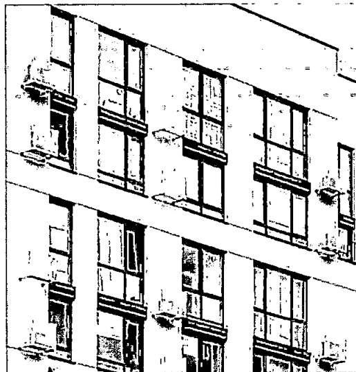
Exemplu de mascare a aparatelor de aer condiționat amplasate pe fațadă cu tablă perforată sursă: https://archimatika.com/en/projects/fayna-town
