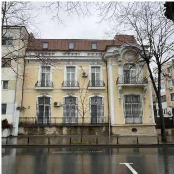
B 514 - Casa N. Pilescu, azi reședința arhiepiscopală
