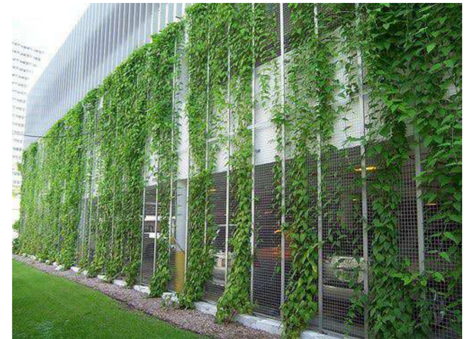
Exemplu de tratare a fațadelor parcarilor supraetajate. Sursa: https://www.rdcollab.com/
