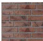
cărămidă aparentă, culoare cărămizie
