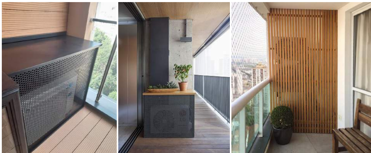
Exemplu de mascare a aparatelor de aer condiționat amplasate pe balcon. a. Tablă perforată b. Riflaj lemn
