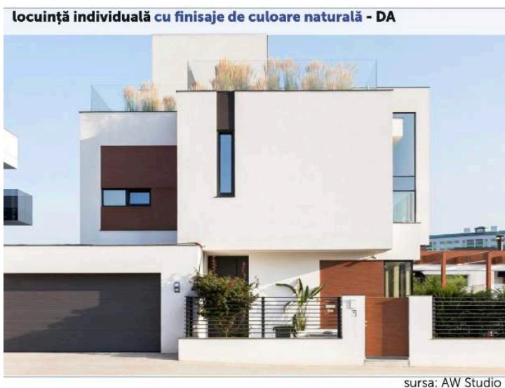
Exemplu tratare fațadă - finisaje, sursă: AW Studio
