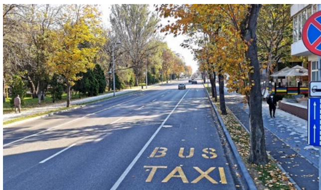
Bandă bus existentă 1 km Bandă bus în lucru 15 km
