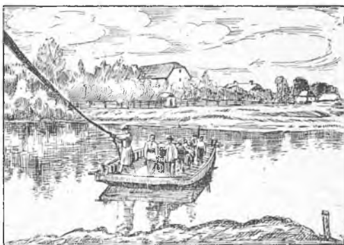
Fig. 3848. Pod umblător pe Mureș.
