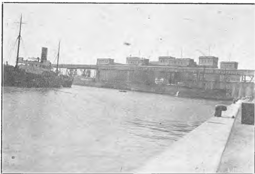
Magaziile cu silozuri
