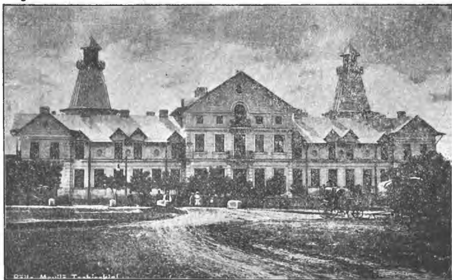
Stabilimentul băilor dela Tekirghiol-Movilă
