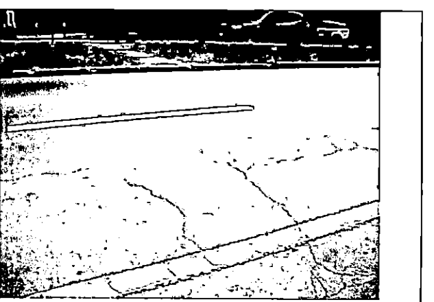
Fisuri si crapaturi cu nivel de severitate ridicat
