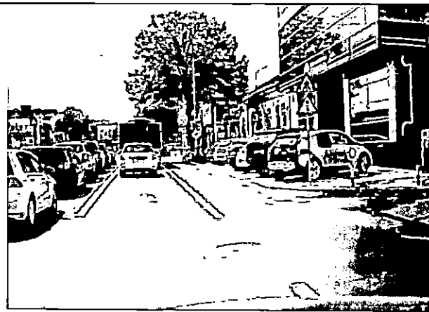
Benzile marginale cu denivelari severe
