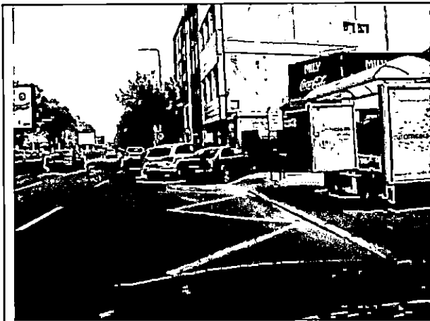
Km 0+954 Statie de bus
