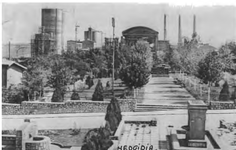
Fabrica “ Cimentul Păcii” în 1963 381
