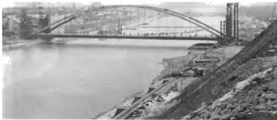
Podul de la Medgidia, în construcție 392
