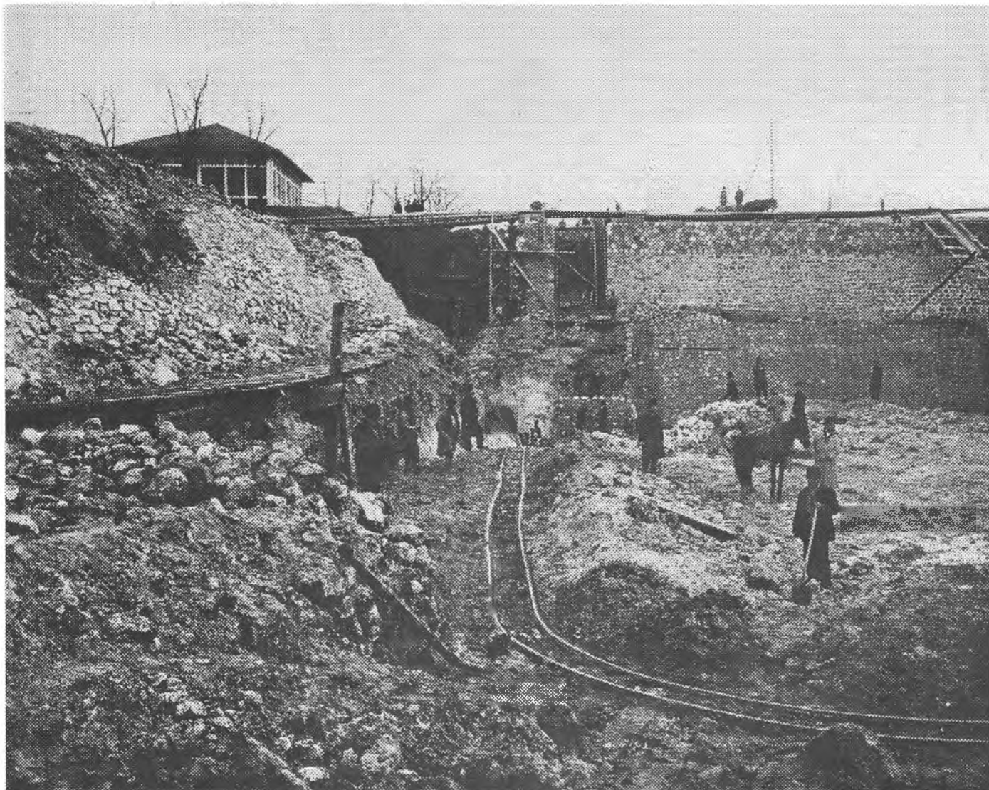
Construcția bazinului docului plutitor
