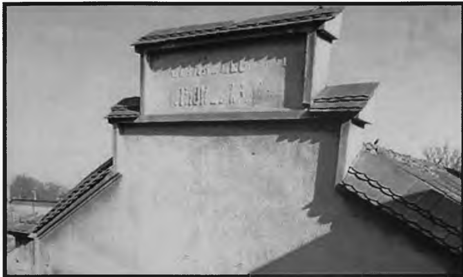
Uzina electrică construită în 1937 125 The electrical factory in 1937
