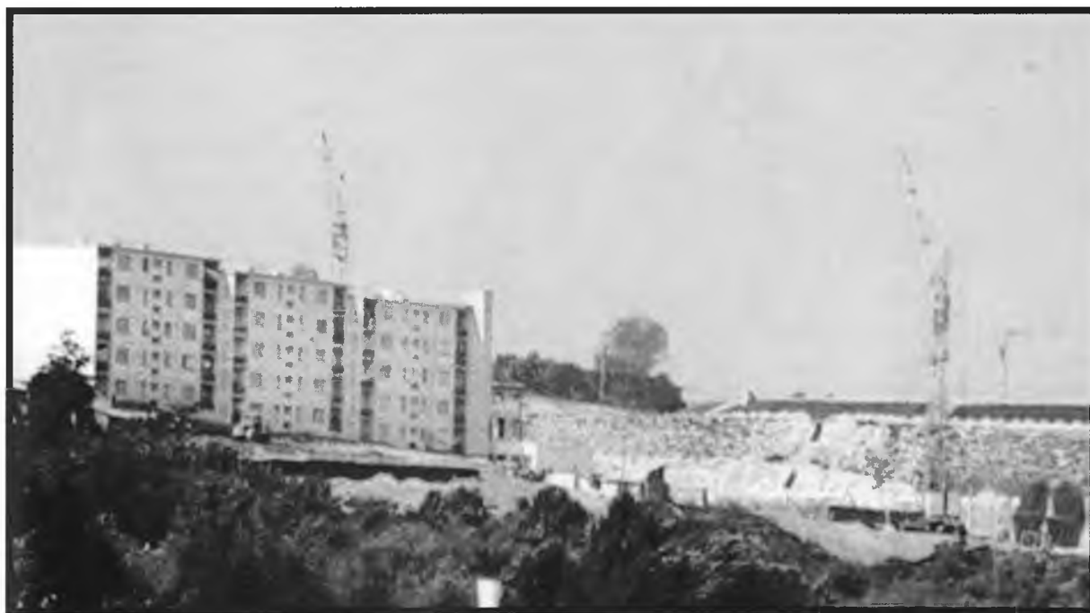
Blocuri în construcție în 1975 215 Block of houses in construction in 1975
