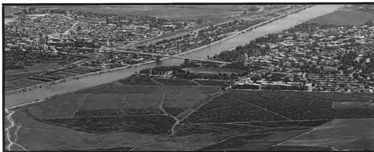
Vedere aeriană asupra oraşului și Canalului Dunăre-Marea Neagră(1985) 241 Aerial view over the town and the Danube-Black Sea Channel (1985)
