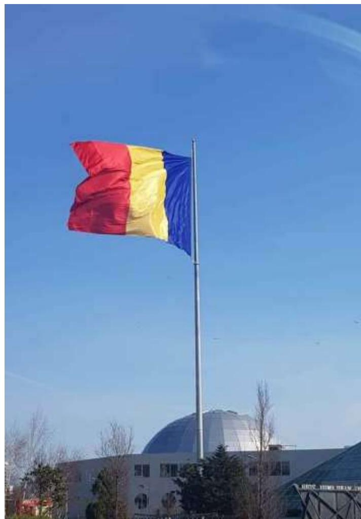
Catargul portdrapel a fost amplasat în incinta Pavilionului Expozițional Constanța, pe platforma pietonală estică, la o distanță de aproximativ 14 metri de scara de acces în Pavilion. Catargul este compus din patru segmente din oțel galvanizat la cald inoxidabil, cu secțiunea variabilă pe înălțime – diametru la bază 650 mm, iar la vârf 200 mm. Înălțimea totală a stâlpului este de 36 m de la C.T.C. – cota de referință – 37,60 m cu paratrăsnetul și sistemul
