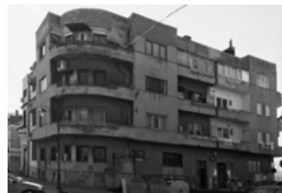
Adresă: Str. Ion Cantacuzino nr.2A-2B
