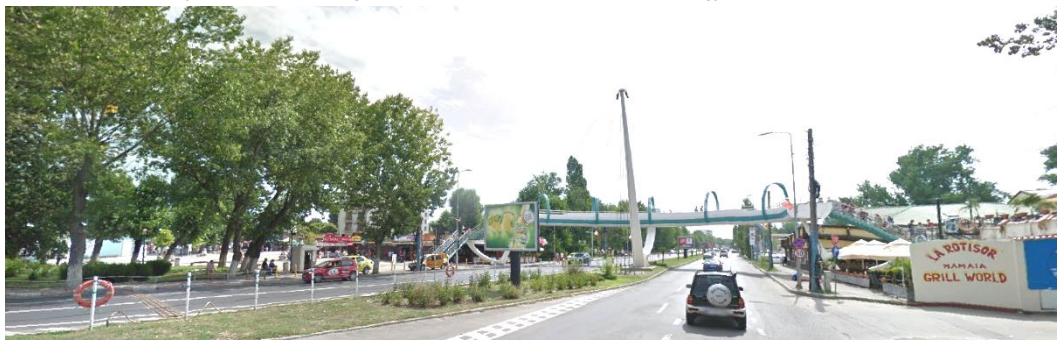
Pasarela - Legătura pietonală realizată peste Bulevardul Mamaia, între Satul de Vacanță (dreapta) și zona de acces către Promenada Mamaia (stânga), Sursa: Google Earth Pro
