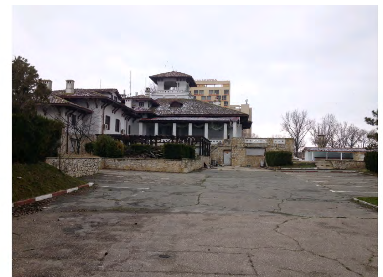
MONUMENTUL ISTORIC FOSTA VILA REGALA, astazi CLUB "CASTEL", - VEDERE DIN DREPTUL PORTII DE ACCES IN INCINTA, DINSPRE VILA STIRBEY - SUD
