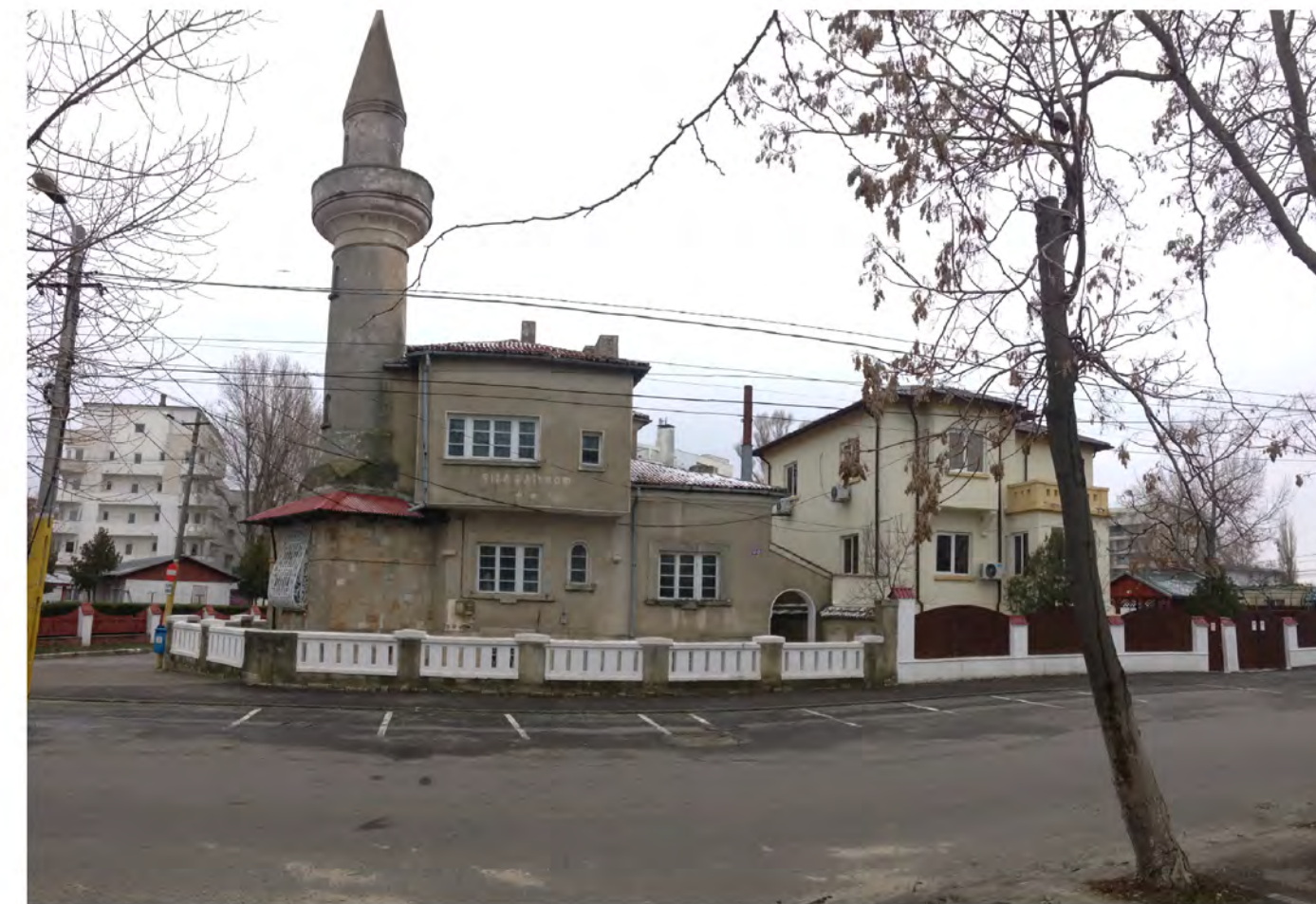
VEDERE VILA SI VECINATATE VESTICA- DINSPRE NORD
