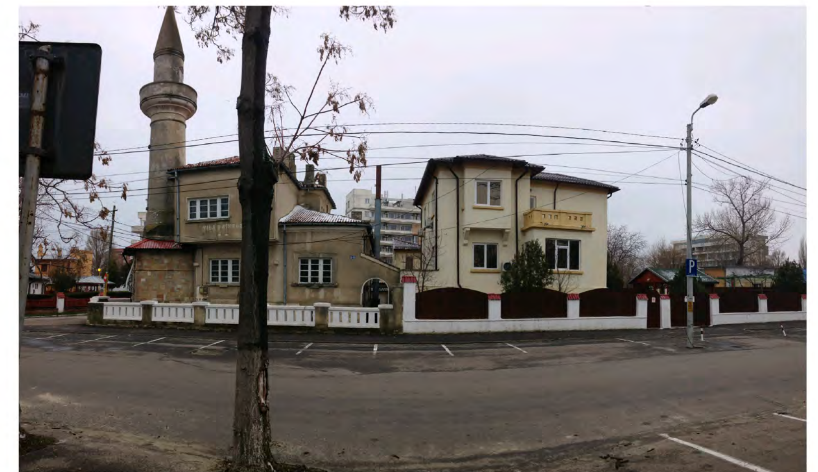
VEDERE VILA SI VECINATATE VESTICA- DINSPRE NORD
