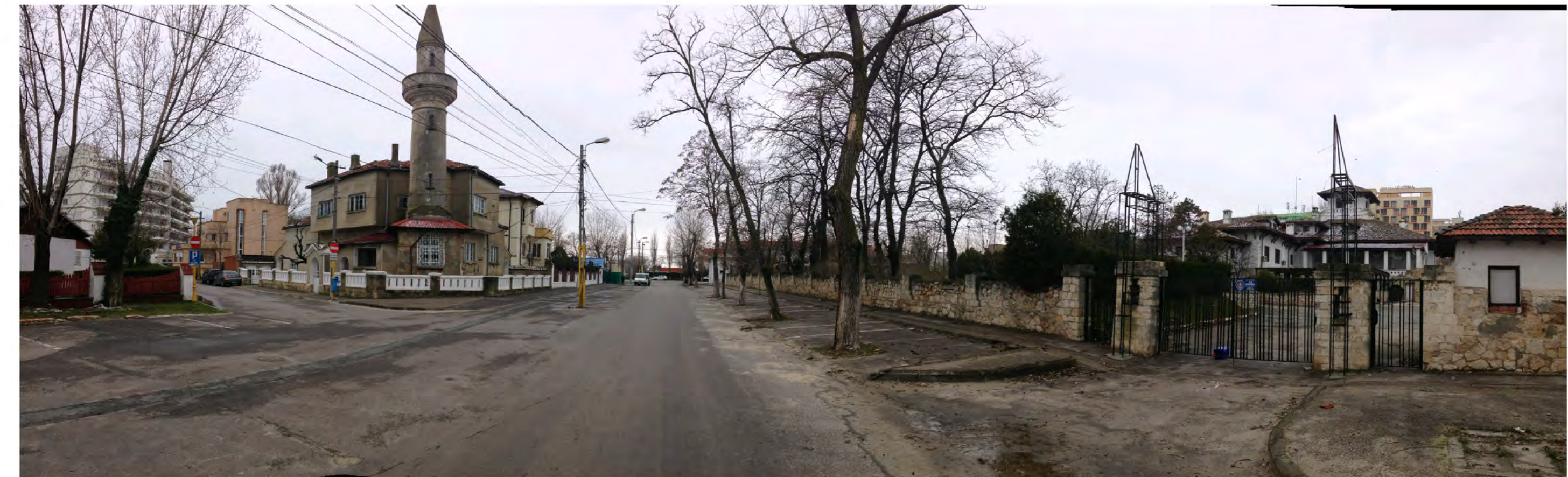
VEDERE VILA SI VECINATATE FRONT STRADAL NORDIC - IMPREJMUIRE SI PORTI DE ACCES IN INCINTA MONUMENTULUI ISTORIC - PERSPECTIVA DINSPRE EST
