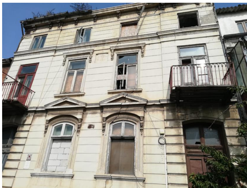
Clădirea din strada C.A. Rosetti 2, în 2018 Clădirea a aparținut lui Teodorou Rousou, negustor grec și a fost construită în 1897
