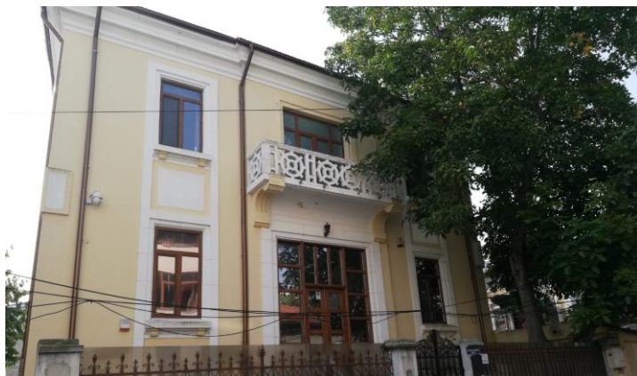
Clădirea din strada Cristea Georgescu, nr. 14, în 2018
