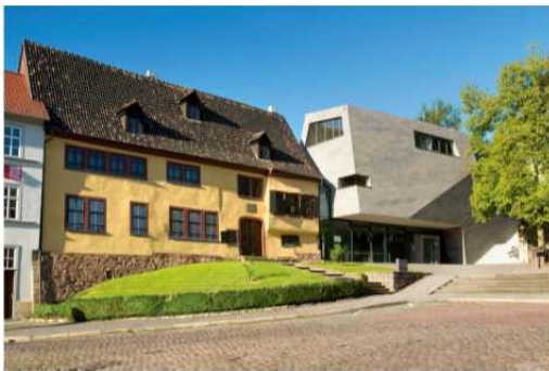
Fig. 6.16. Bachhaus in Eisenach
