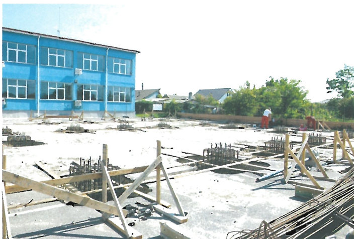
Șantier construire Grădinița cu orar prelungit / Building site of the day nursery
