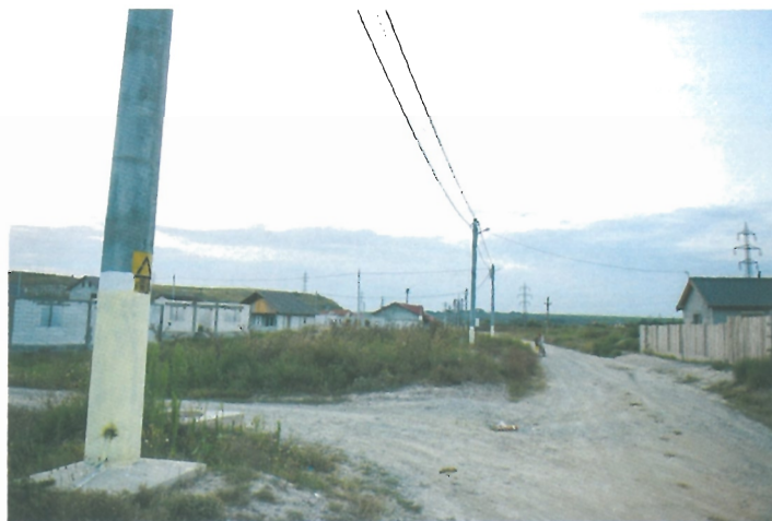
Introducere rețea de iluminat cartier Afumați / Setting of the lighting network in Afumati
