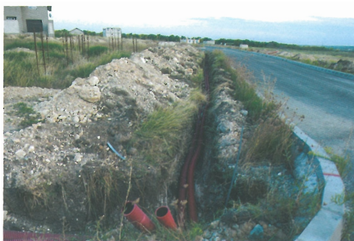
Introducere rețea electrică pentru consum casnic în cartierul nou al comunei – Zona F /
