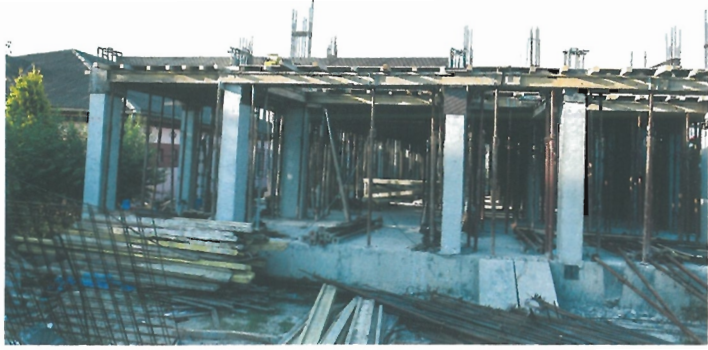
Santier sală de sport în curtea Școlii gimnaziale nr. 2 / Construction site of the Sports hall in the courtyard of School no. 2
