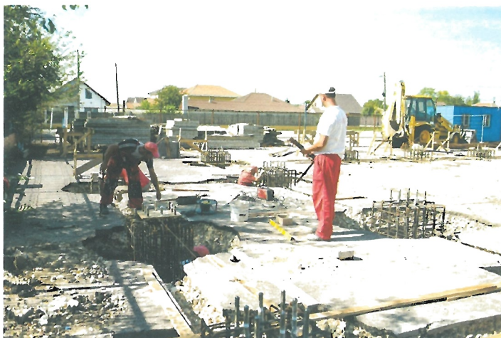
Șantier sală de sport în curtea Școlii gimnaziale nr. 2 / Construction site of the Sports hall in the courtyard of School no. 2
