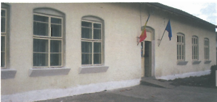
Așa arăta în 2004 înaintea perioadei de modernizare Școala Valea Seacă / This is how Valea Seacă School used to look like before the modernization period
