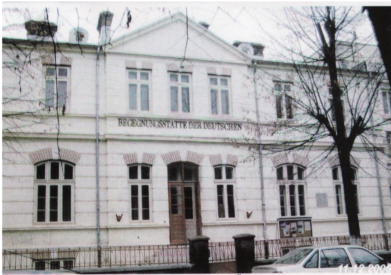
Clădirea renovată a BEGEGNUNGSTÄTTE – CONSTANȚA
