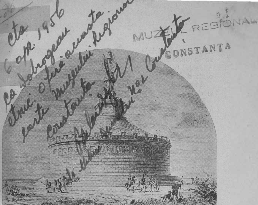
Monumentul Adamklissi restaurat.
