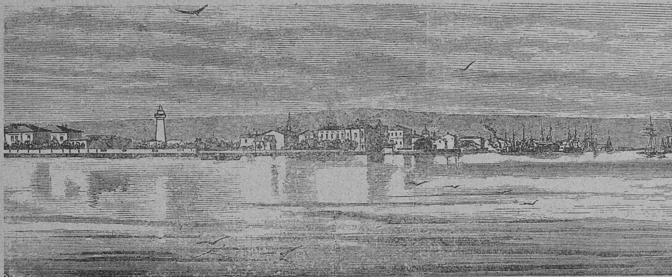
Vederea generală a portului Sulina (1880).
