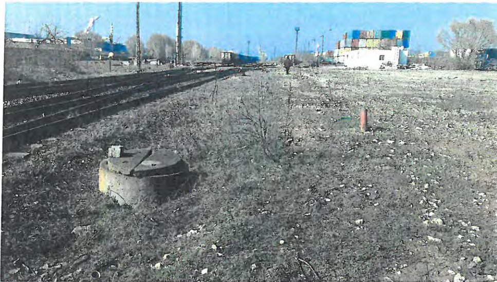
Foto 1: Cai ferate pe zona de vest a amplasamentului
