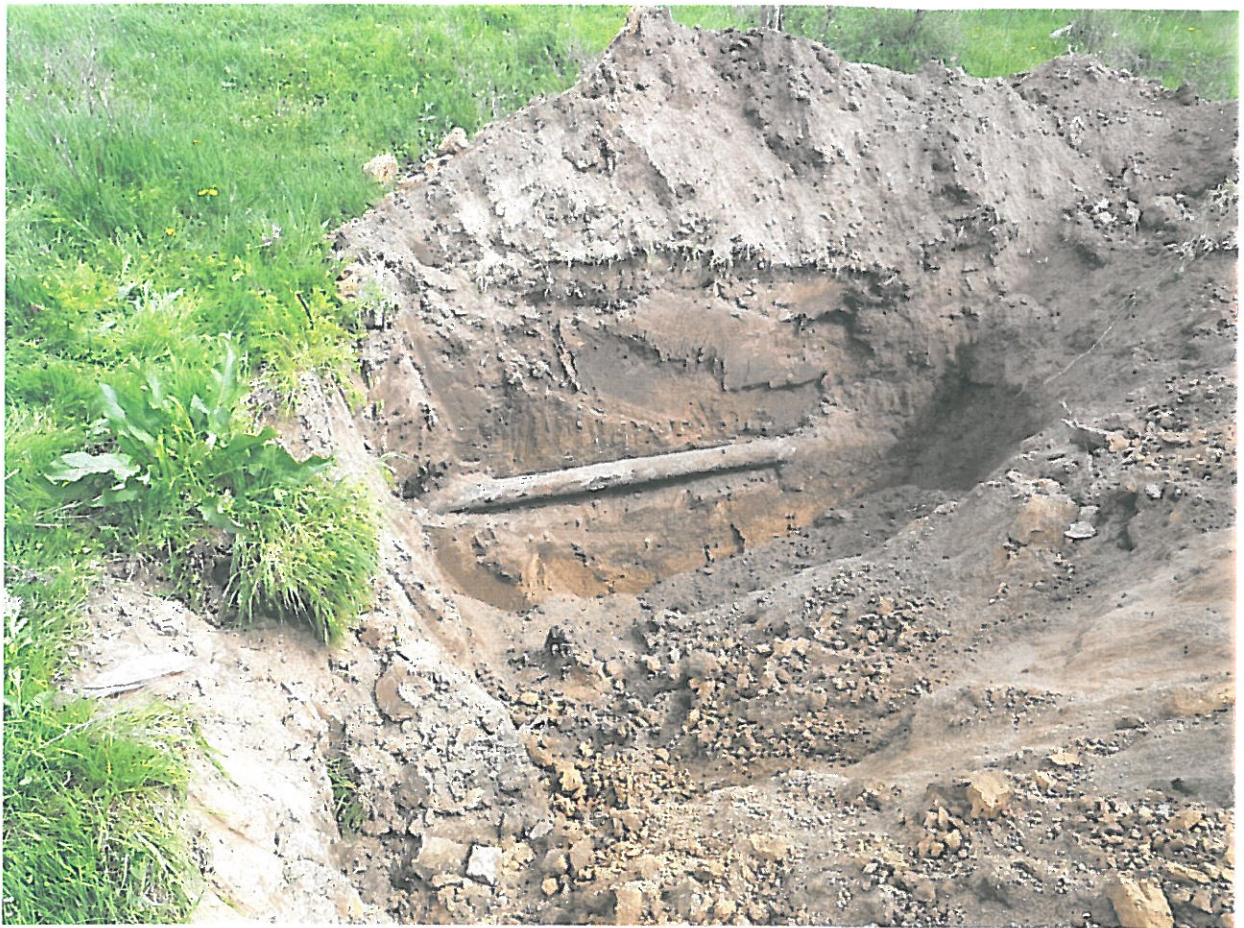
Sondaj Strada Bisericii – zona Vest
