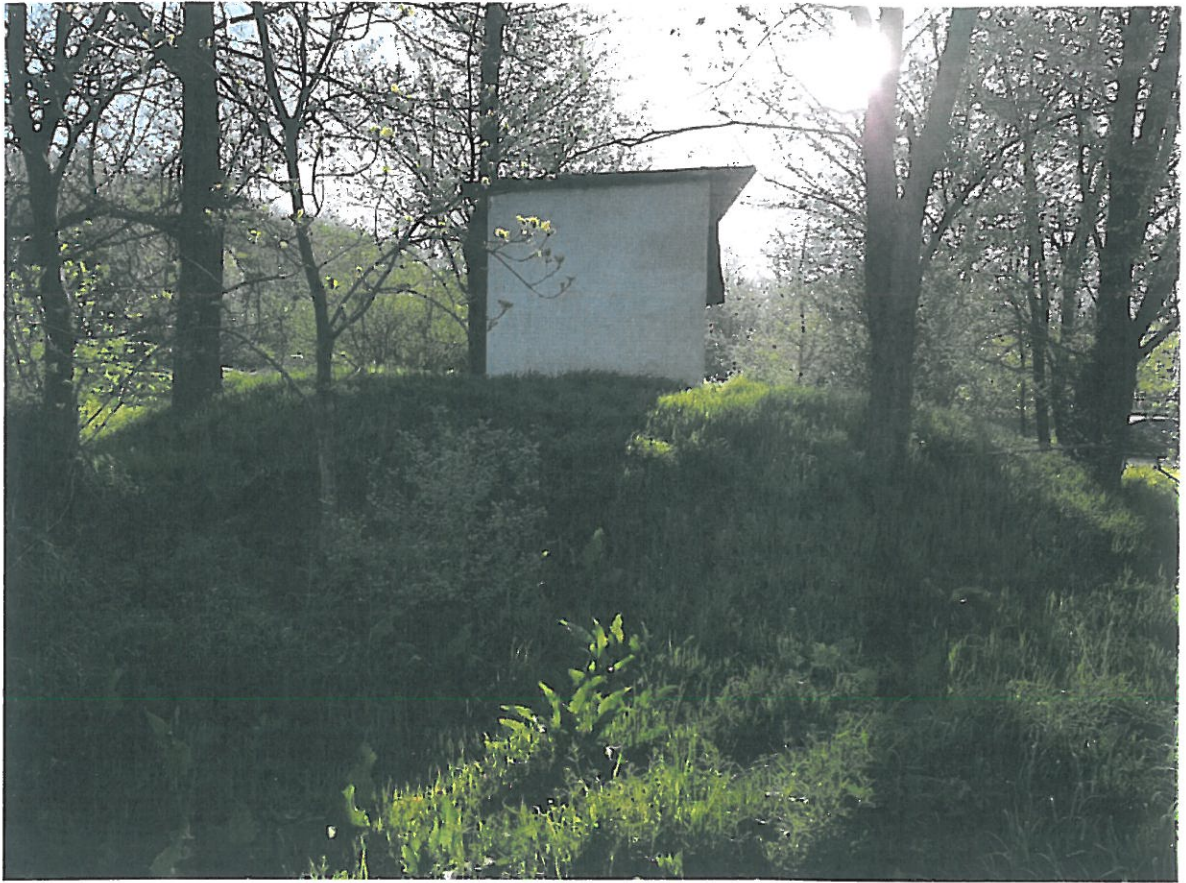
Statie clorinare captare
