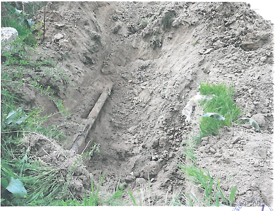
Sondaj Strada Agricultorilor
