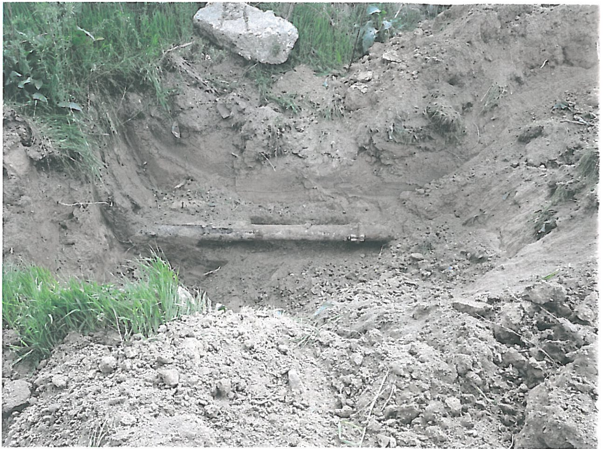
Sondaj Strada Agricultorilor
