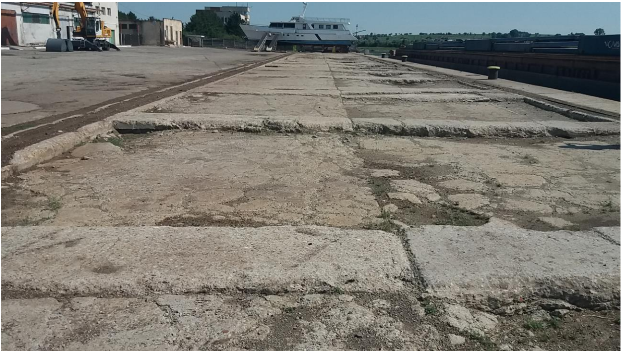
Figura nr. 3-1 –Zona de Est a platformei danelor 1,2 si 3
