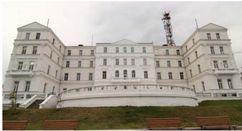
Comandamentul Marinei Militare (în rehabilitare, termen 2018). Sursă: ziuconstanta.ro
