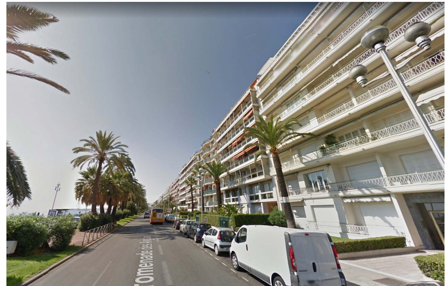
Coerență arhitecturală și cromatică în zona de promenadă din Nisa, Franța.
