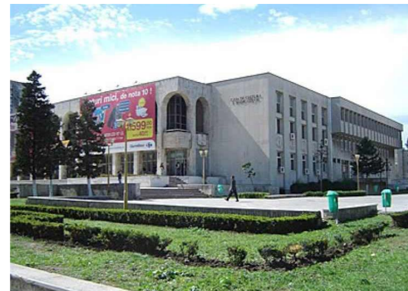
Casa de Cultură, acoperită de panouri publicitare. Sursa: zilesinopti.ro
