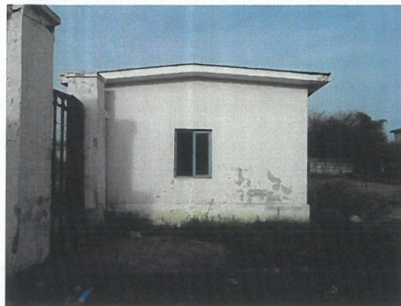
Vedere generala statie pompare C8
