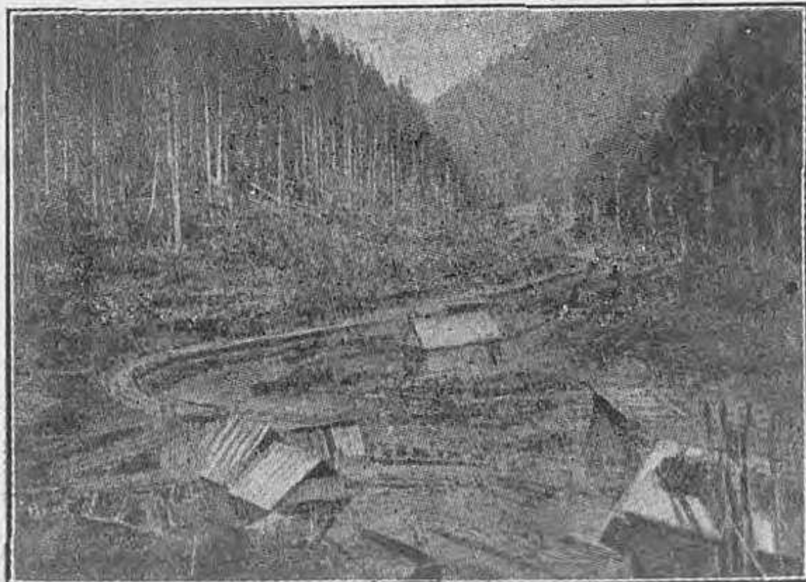
Tăiatul scândurilor la munte
