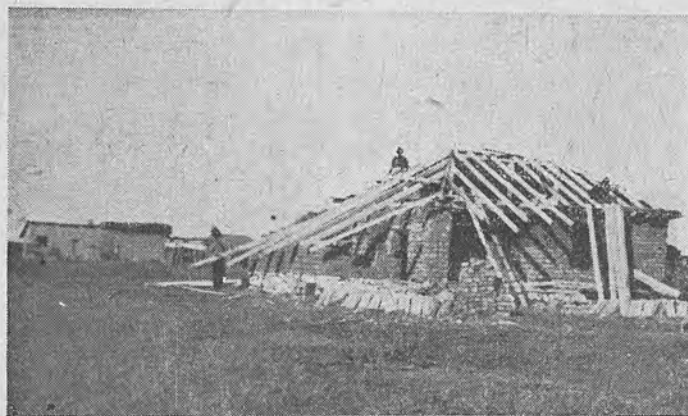
Casă în construcție la coloniștii regățeni.
