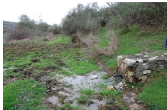
Foto 4 Rigola orizontala colmatata pe bancheta orizontala si dren transversal
