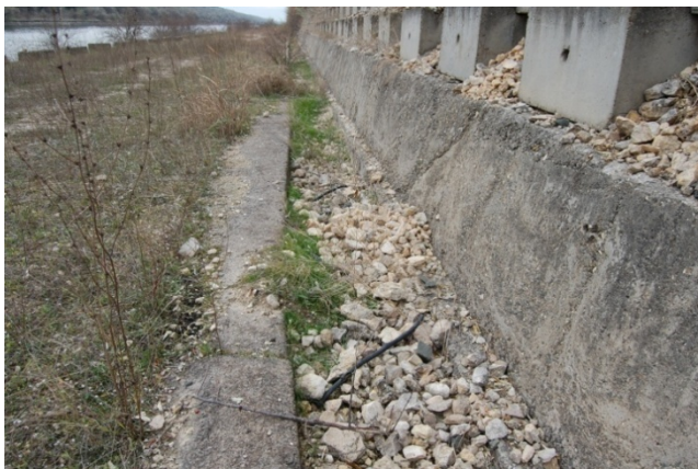
Foto 3 Rigola ranforsata pe drumul tehnologic de la cota +10mrMB colmatata cu piatra
