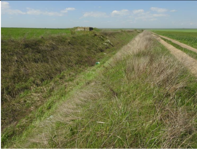
Fig. 22 Canal în zona kilometrului 2+300 al conductei care va fi traversat de aceasta
