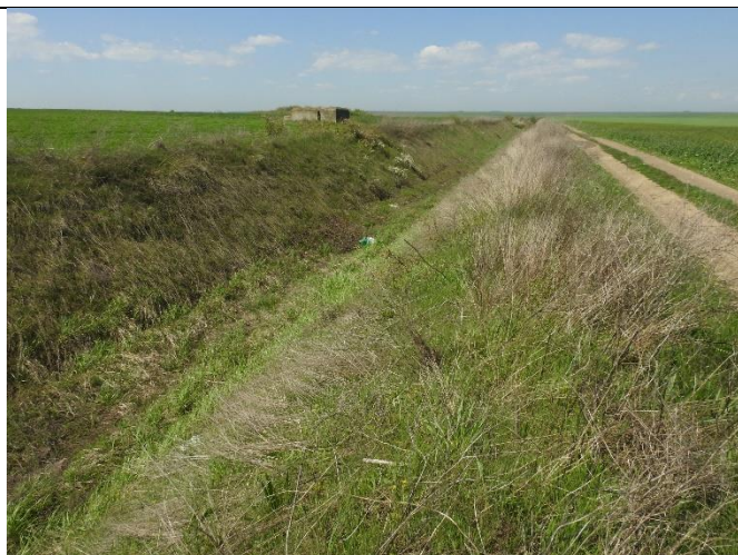
Fig. 26 Canal traversat de conductă în zona kilometrului 3
