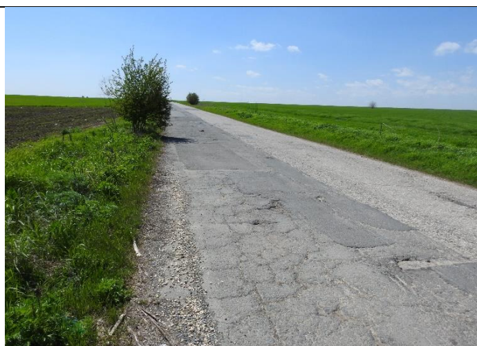
Fig. 16 Drumul DC 83 ce intersectează proiectul în zona km 0
