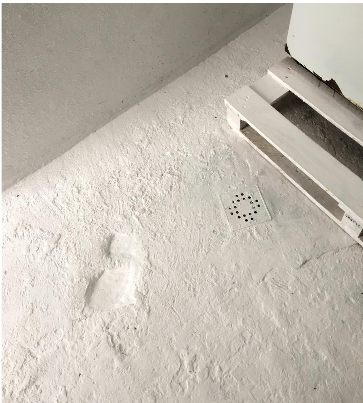
Foto 4: Sifon de colectare a apelor rezultate din igienizarea incintei
