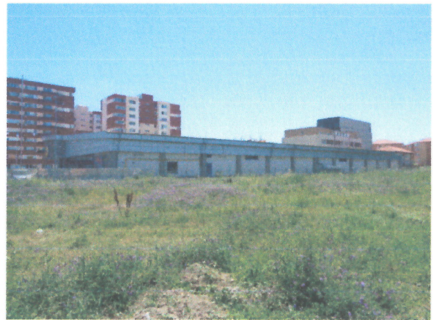
Vedere generala proprietate
