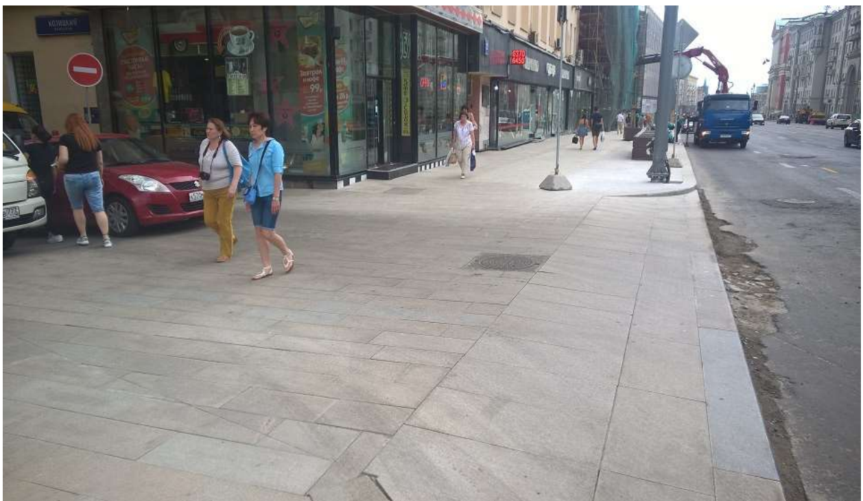
Foto: Detalii de traversari pietonale la nivel cu trotuarul.
