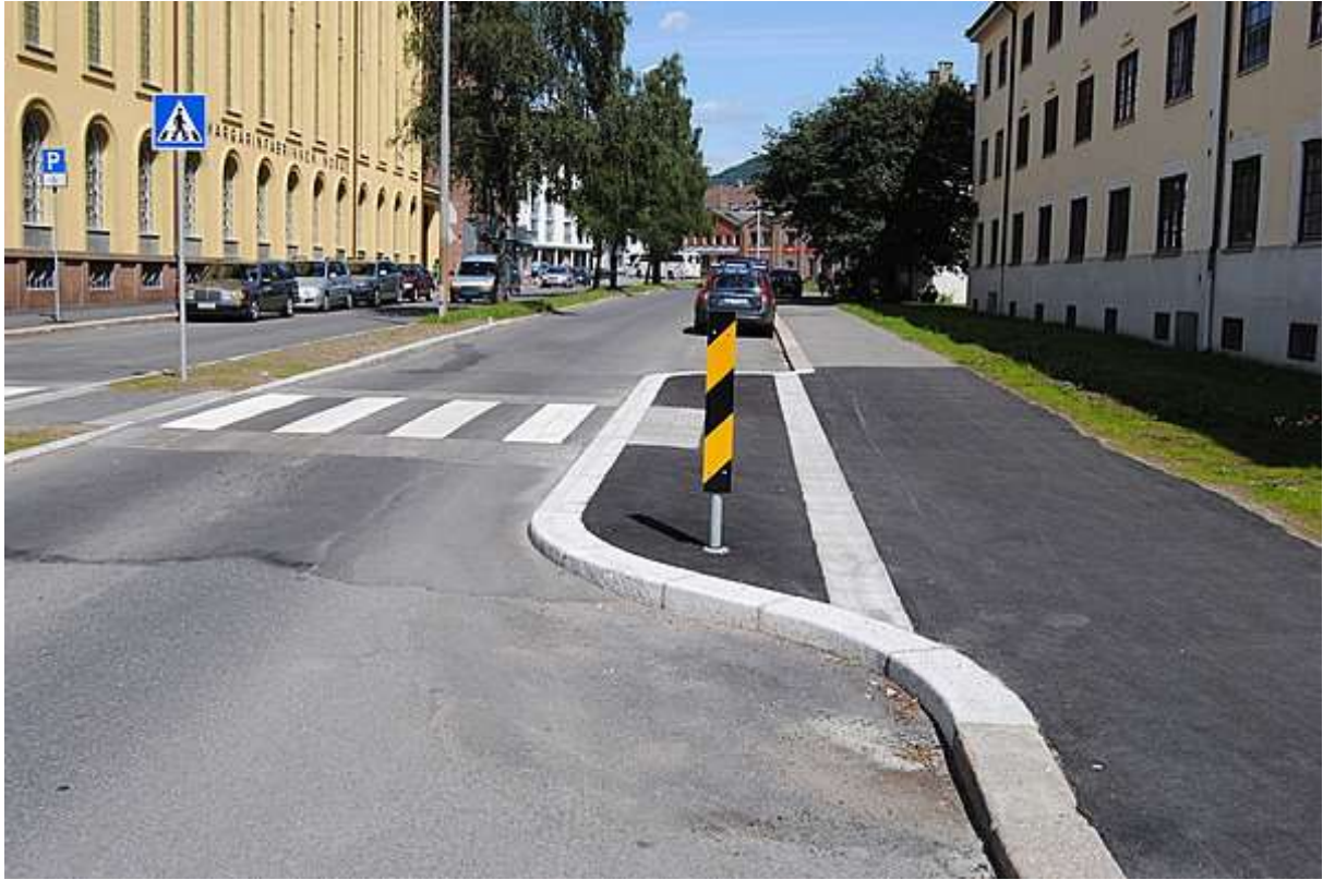
Foto: Simulare 3D - Trecere de pietoni cu distanta redusa, insula de odihna (cand este cazul) si ridicarea suprafetei de traversare la nivelul trotuarului pentru siguranta pietonilor.
