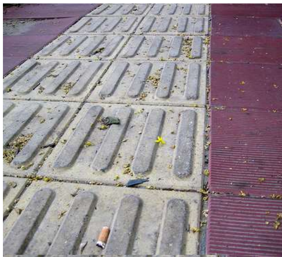
Foto: Detaliu pavaj tactil pentru deplasare
