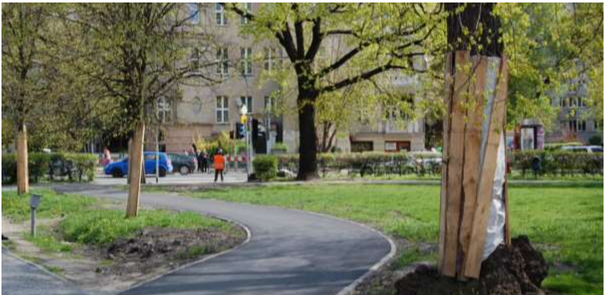
Foto: In Uniunea Europeana trunchiurile copacilor sunt protejate in timpul executarii lucrarilor de constructie.
