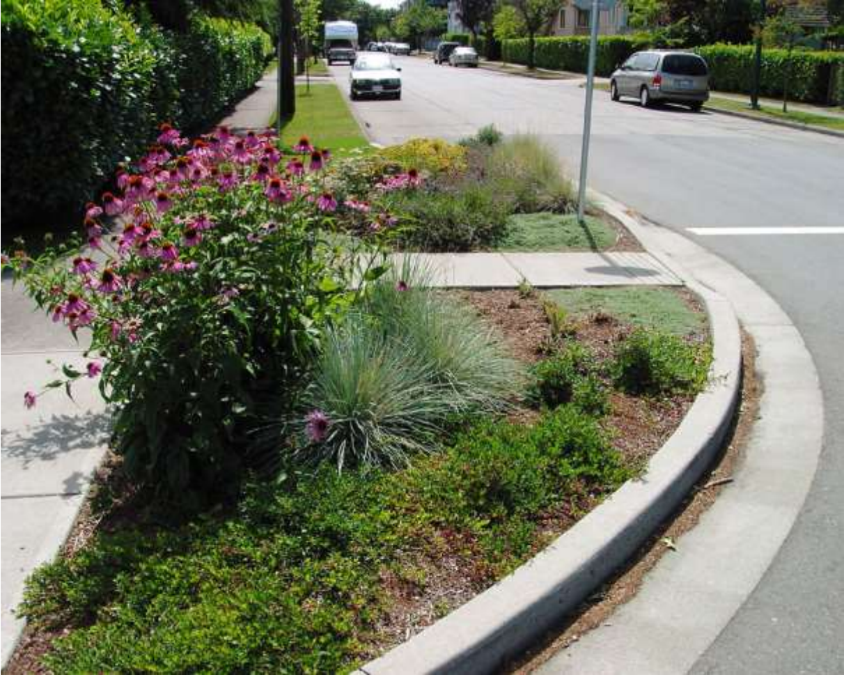
Foto: Exemple de gradini pluviale la intersecatii si treceri de pietoni
