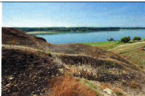
▲ Zid Sector Incinte vest – segmentul sudic
