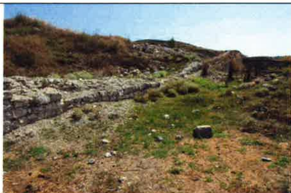
▲ Zid Sector Incinte vest – segmentul de nord
