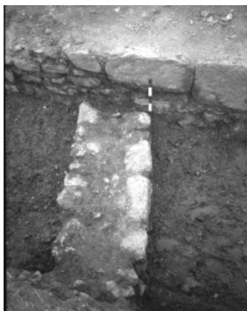
Fig. 7 – Ovidiu 2002. Zidul de nord al edificiului B tăiat de incinta inițială
