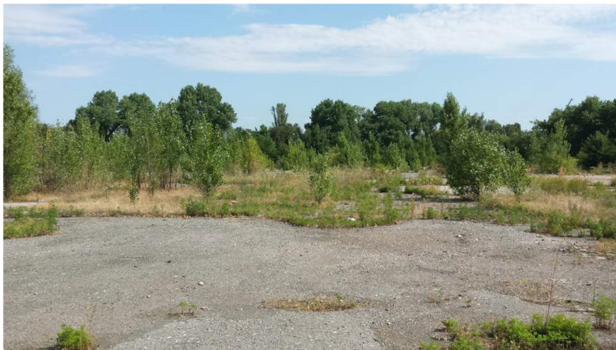
Foto 2: Vedere de pe amplasament- platforma betonată degradată , cu vegetație spontană
