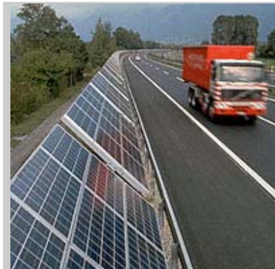
Figura 10: Instalarea barierele antizgomot cu panouri solare pe o autostradă.
