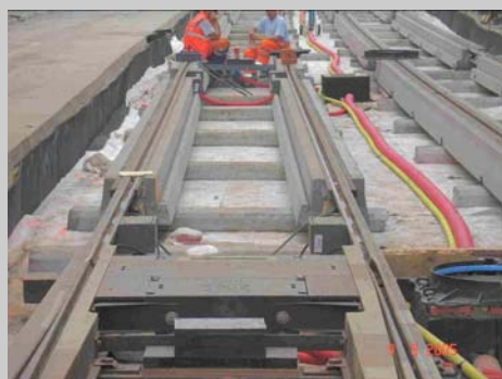
Figura 4: detalierea sistemului de aplicare a lubrifianului.
