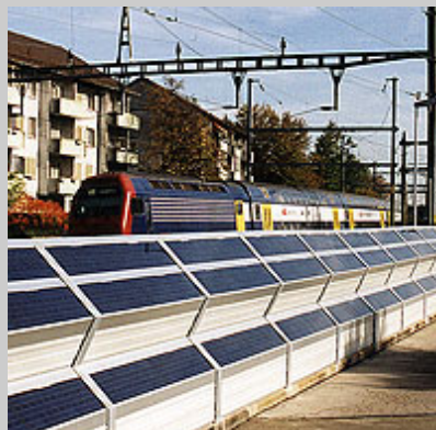
Figura 9: Ecran sonor cu panouri fotovoltaice pe o linie de cale ferată
